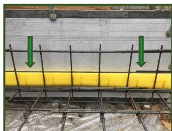
型枠側面と鉄筋の間に切欠きパットを
