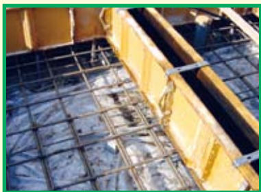
7 内部立ち上り部パネルの組付けをします。
