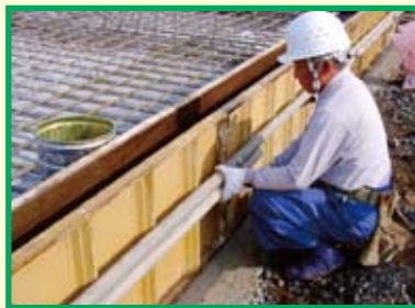
5 パイプ等で通りを出し、サポートなどで固定します。
