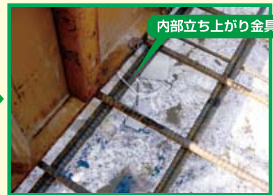
6 内部立ち上がり部に金具を設置していきます。(450ミリ~600ミリの間隔で)
