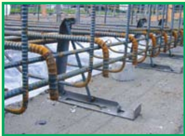
1 外周通りに墨出し後、外周金具をコンクリート釘で取付けます。(500ミリ以内の間隔で)
