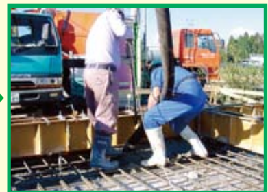
9 コンクリート打設は、外周ベース部→内部立ち上りベース部→外周立ち上り→内部立ち上りの順で打ち、最後に土間部分の打設を行います。
