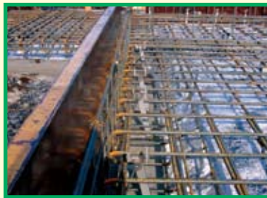
2 外周パネルの組み立てをします。
